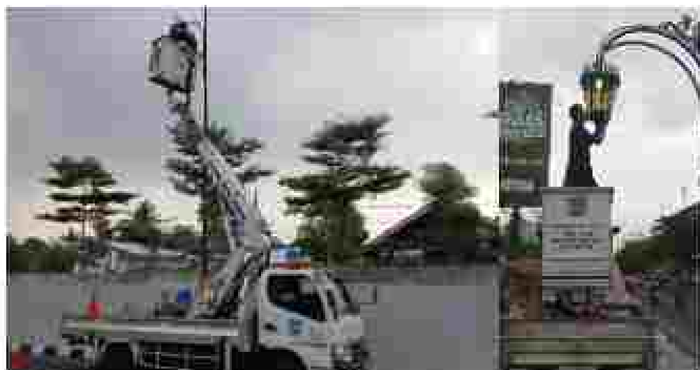
Gambar : Pemeliharaan Penerangan Jalan Umum
