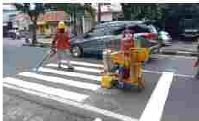
Gambar : Pengadaan Marka Jalan
